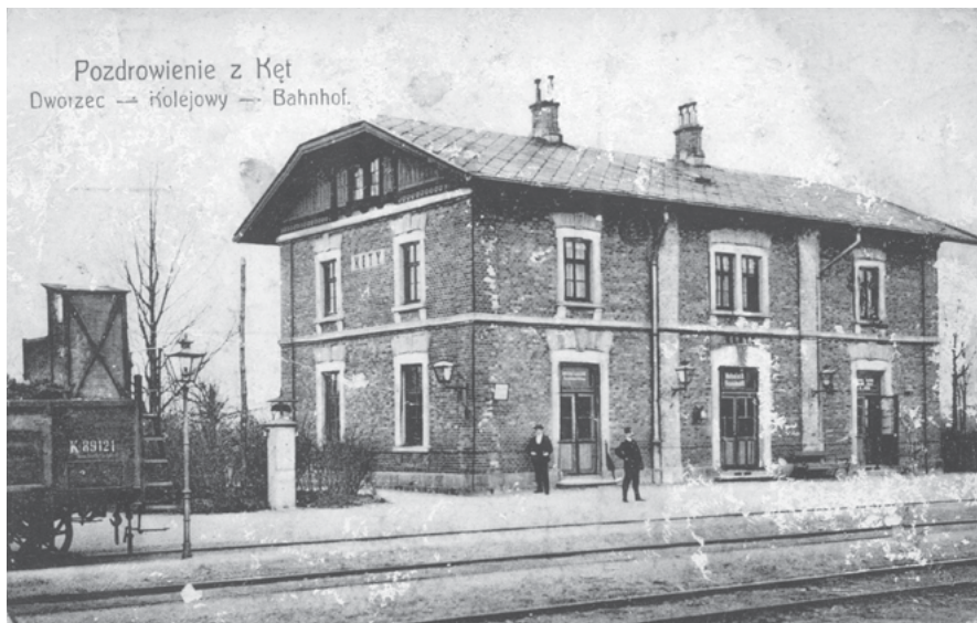
Budynek stacji kolejowej w Kętach ok. 1905 roku (ze zbiorów A. Wojtali)
